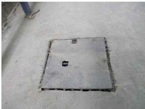
รูปที่ 53 วางระบายน้ำและปิดกั้นตะกอน
