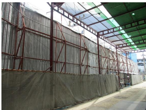
รูปที่ 8 รว Metal Sheet สูง 6 เมตร ล้อมรอบบริเวณพื้นที่โครงการ
