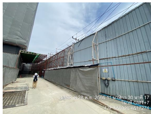
รูปที่ 8 รว Metal Sheet สูง 6 เมตร ล้อมรอบบริเวณพื้นที่โครงการ
