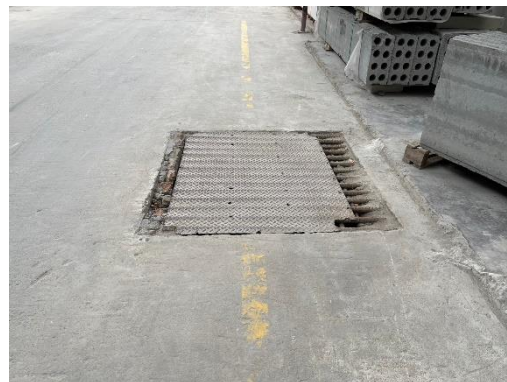
รูปที่ 53 วางระบายน้ำและปิดกั้นตะกอน
