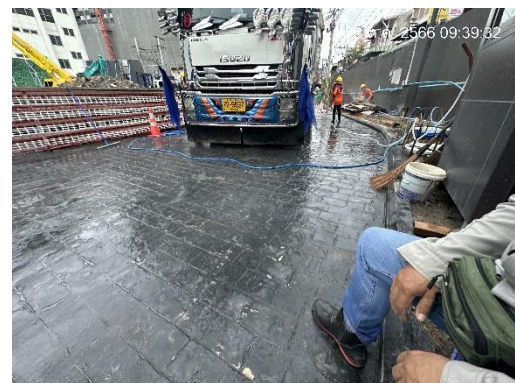
รูปที่ 20 พื้นที่ล้างล้อรถบรรทุกก่อนออกจากโครงการ
